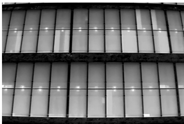
写真-7.4.1 クラスタ異常に伴う高温化例。ジャンクションボックスの一定程度以上の高温化を伴う場合は、焼損に至る可能性がある
